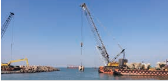
दाभोल एलएनजी टर्मिनल पर निर्माणाधीन ब्रेकवाटर
