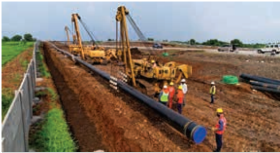
एमएनजीपीएल परियोजना के तहत मुंबई से नागपुर तक प्राकृतिक गैस पाइपलाइन बिछाते हुए
