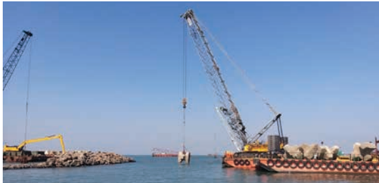
Breakwater under construction at Dabhol LNG Terminal
